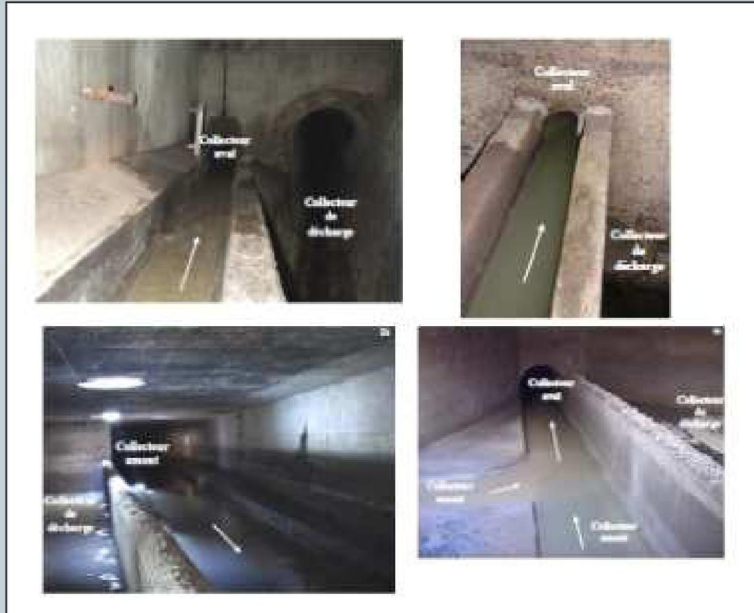
Figure 21 : Exemples de déversoirs à seuil latéral.
