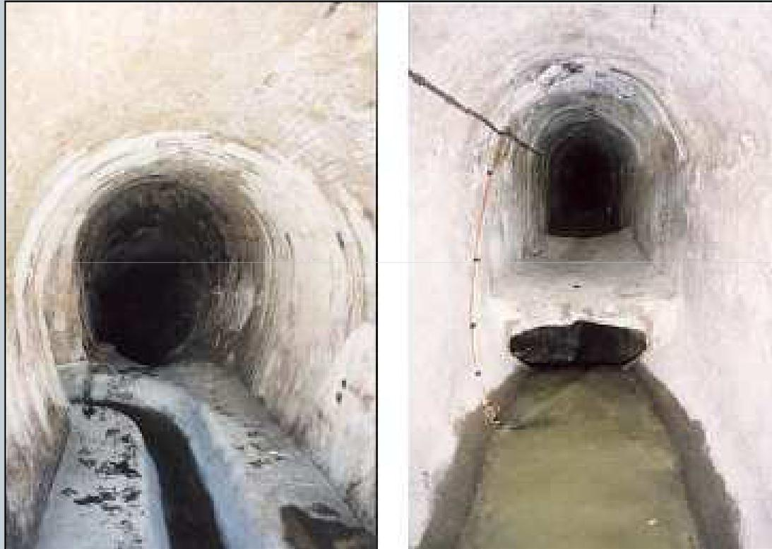
Figure 23 : Exemples de déversoirs à seuil frontal.
