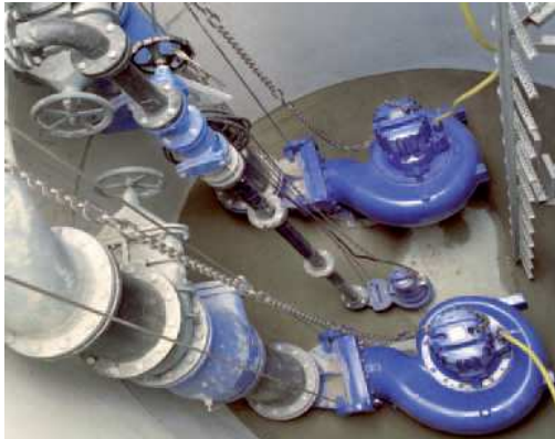
Fig.5.9 Pompes submersibles en fosse noyée
