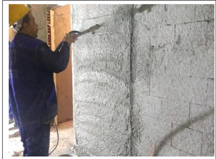
Projection d'enduit sur les murs intérieurs
