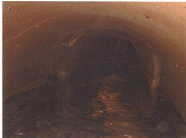
Joint en mortier à réaliser entre les 2 tuyaux de DN différents
