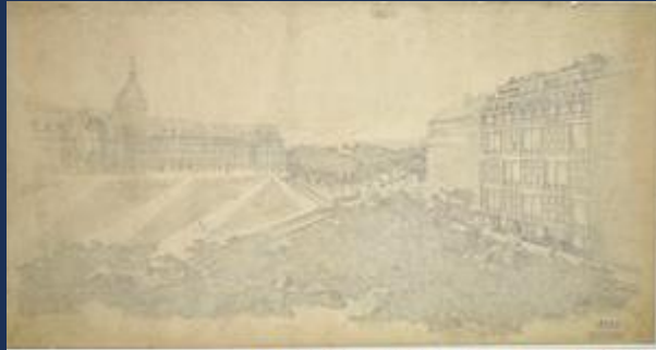
Immeuble Invalides, rue Fabert, Paris
