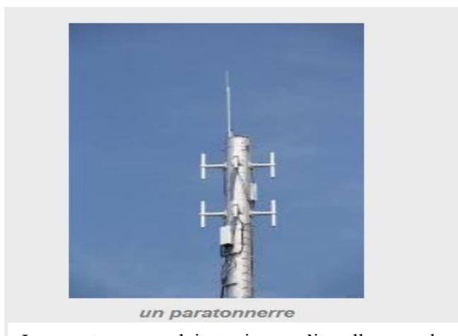
Le paratonnerre doit toujours s'installer sur la partie la plus élevée de l'édifice ou la structure à protéger.
