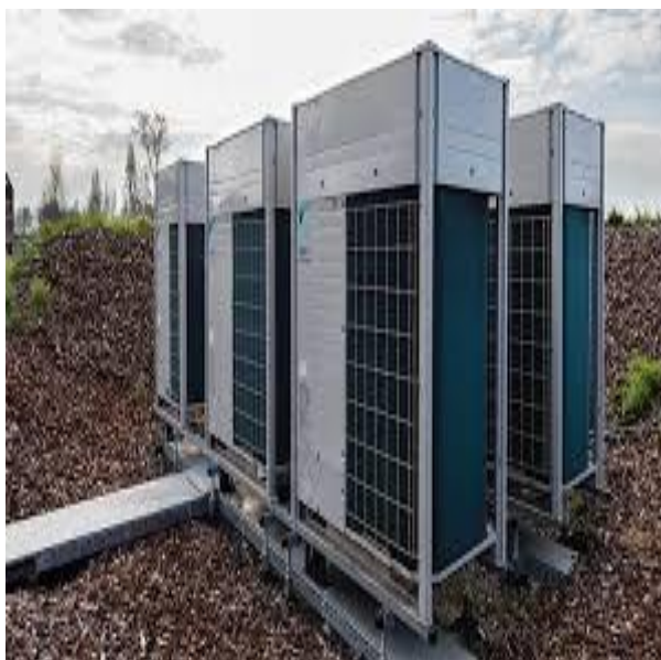
Fig.9a : Climatiseur VRV.
