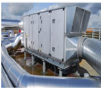
Fig.10 : Centrale traitement de l'air
