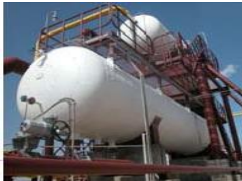
Fig. 3.4 : Séparateur gaz-liquide
