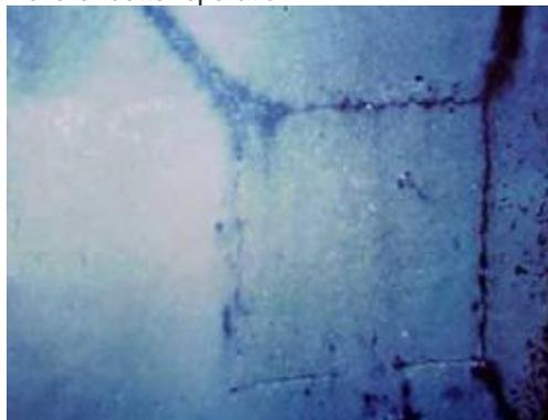
Fig. 7 : Fissuration par concentration de contraintes en zone de fort bridage
