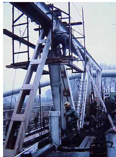
Fig. 2 : Remplacement d'un montant d'une poutre treillis – dispositif provisoire de reprise des efforts par barres de brelage
