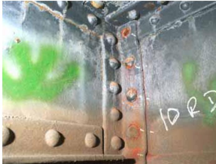
Fig. 6 : Déconsolidation d'assemblage rivé avec rupture de rivet
