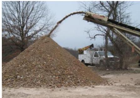
**Concassage mécanique de résidus de démolition d'un bâtiment.**
