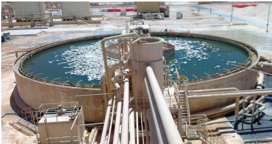
fig 1 bis. Epaississeur à un seul étage (réel)
