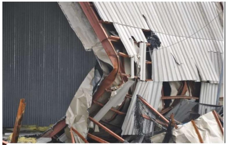
Rupture par flambement d'un poteau en acier
