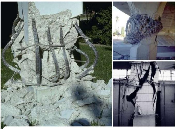
Rupture par flambement de poteaux en béton
