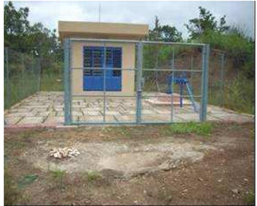
Le forage capte les formations du socle, ou l'eau circule dans les fractures du granite, captées à partir de 43m.
