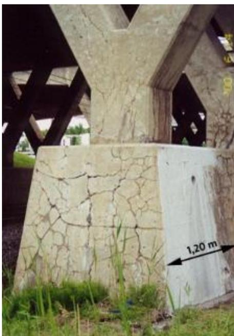
Figure 1: Exemple de béton dégradé par l'alcali-réaction
