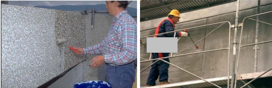
*Application d'un inhibiteur*
