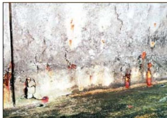
*Corrosion par piqûres liées aux chlorures*
