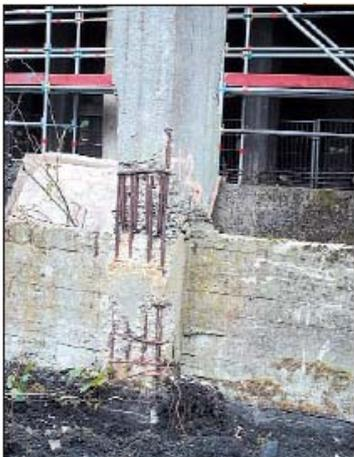
*Corrosion des armatures par carbonatation*
