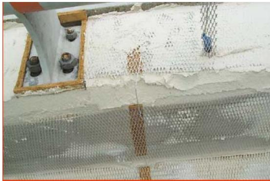
Pose de l'anode (anode sacrificielle)
