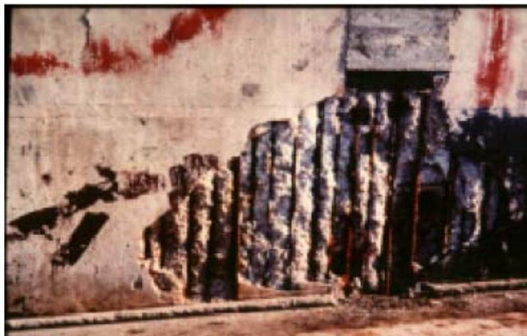
Fig 1 : Phénomène de dégradation du béton, corrosion des armatures
