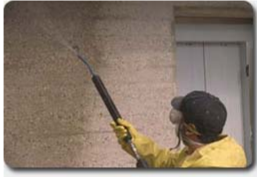
Figure 18 : Technique de restauration d'une surface atteinte par la carbonatation
