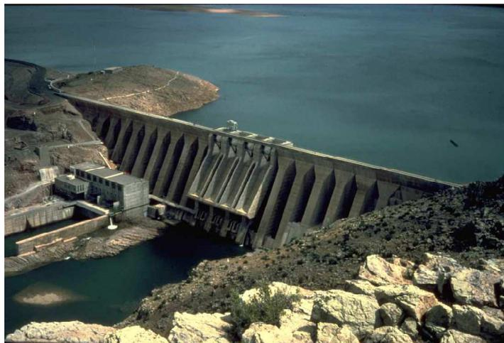
Fig. 2-6 : Barrages à contreforts, barrage Al Massira Maroc
