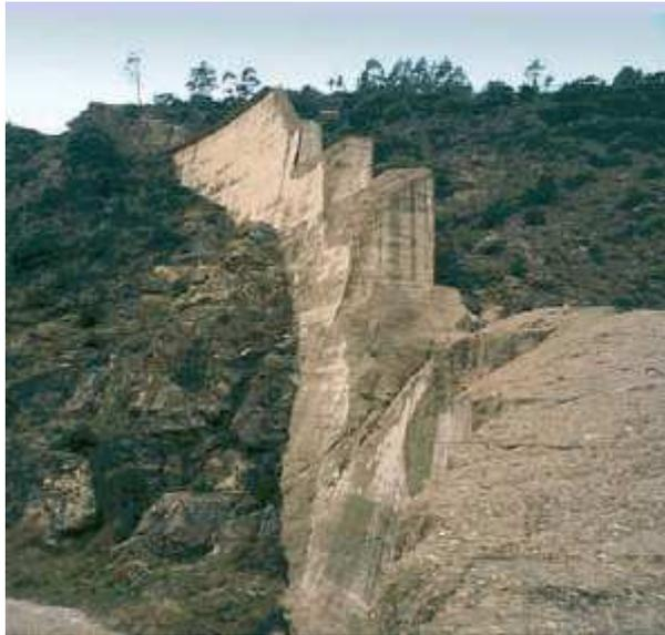
**Fig. 1-15 : Rupture du barrage Malpasset (Var, France, 1959).**
