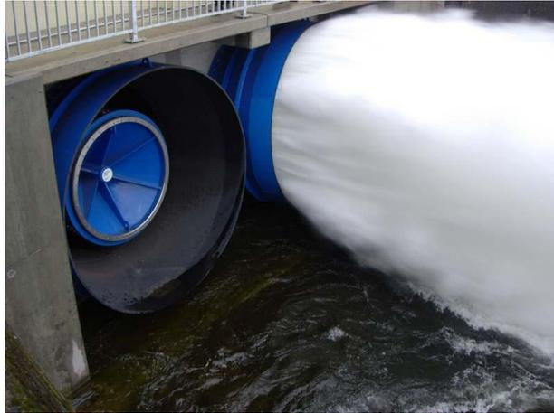
**Fig. 5-27 : Vanne à jet creux**
