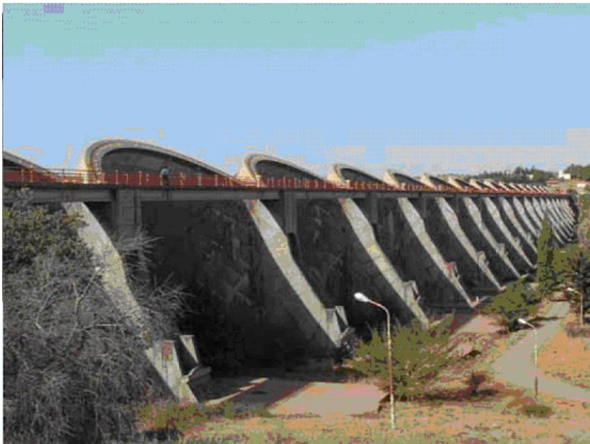
**Fig. 2-8 : Barrage à voûtes multiples, Barrage Meffrouch Algérie**
